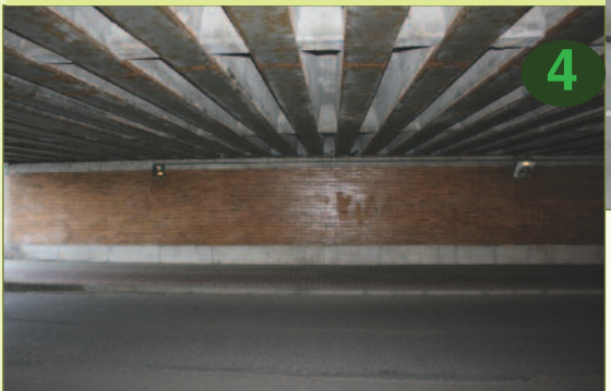
De bestaande donkere tunnel G.Gezelleplaats kan gedeeltelijk open worden gemaakt.
