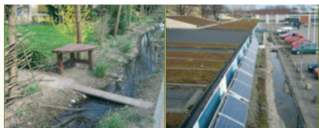
Fig.7 Wadi's in de wijken [ Water Afvoer Door Infiltratie ]
