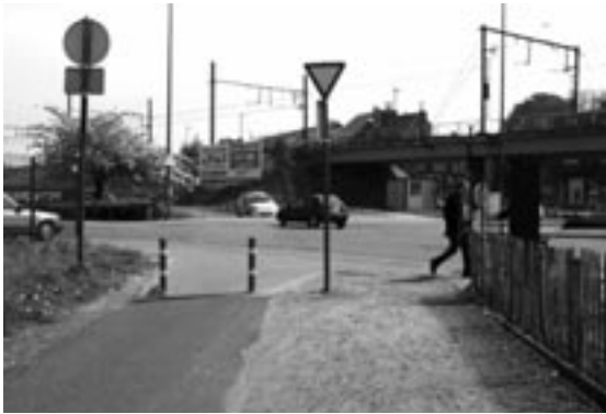
Kruispunt Driekoningen in Sint-Niklaas: levensgevaarlijk is het om hier de fietsroute te bereiken.
