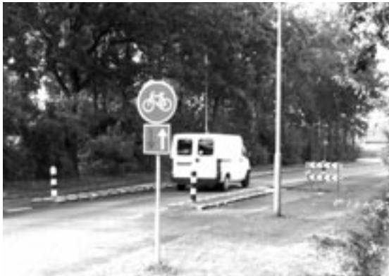
Een wegversmalling ter hoogte van de oversteekplaatsen is absoluut noodzakelijk in straten met twee baanvakken.
