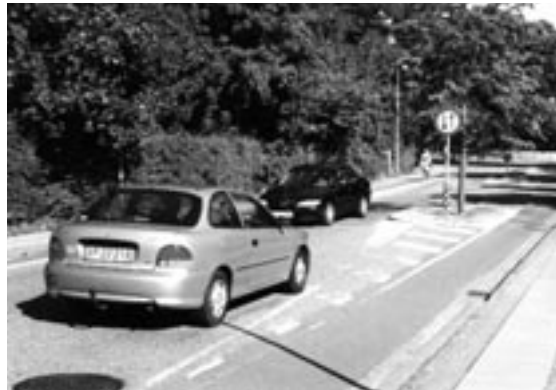
Op deze manier kunnen nooit twee auto's uit tegengestelde richting tegelijk de spoorwegkruising bereiken.
