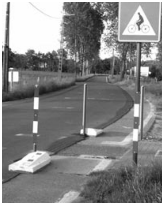
Betonblokken versperren de weg voor fietsers die naast elkaar rijden in de 's Hondstraat (Sint-Gillis)
