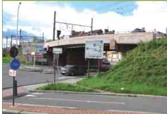
In de voorgrond de toegang tot de verderop gelegen fietsbrug (Kortrijk).
