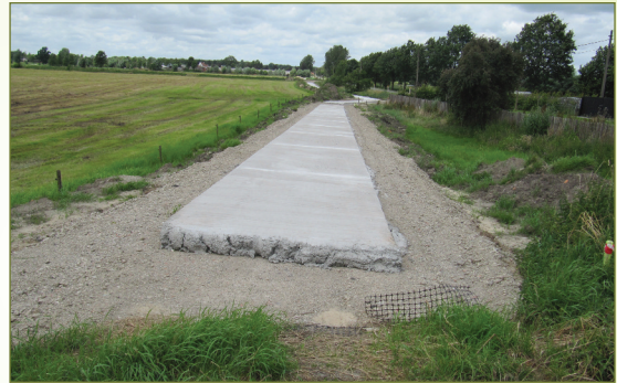
afb. 4. In aanleg zijnde nieuw fietspad 40 m naast Koebrug, dwars door open ruimte. Daar hoort een nieuwe fietsbrug bij, op de plaats waar de fotograaf staat. Geld en groene ruimte teveel?
